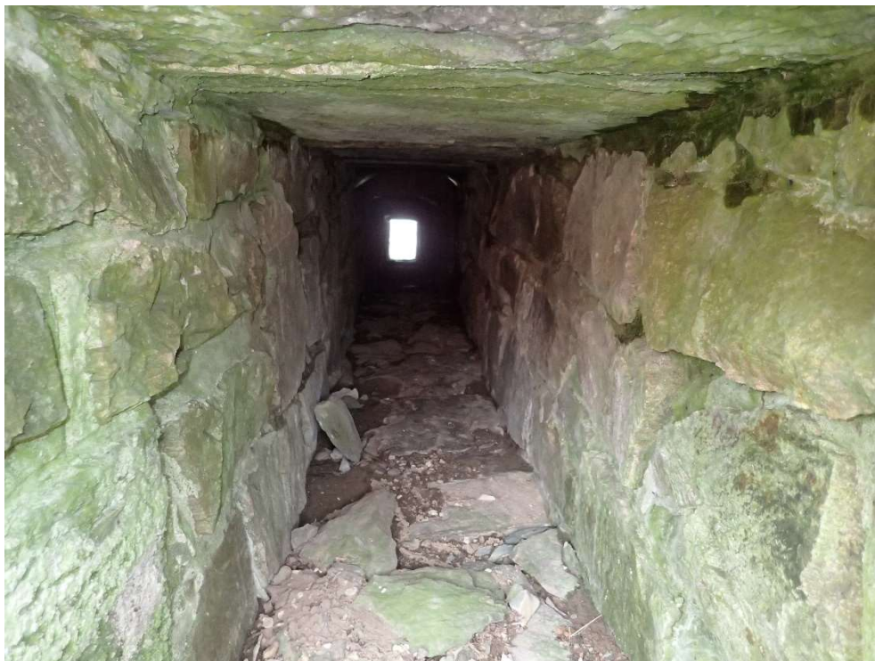
Foto 3: Místy uvolněné kameny, vypadané spárování, průsaky vod skrz kamenné zdivo
