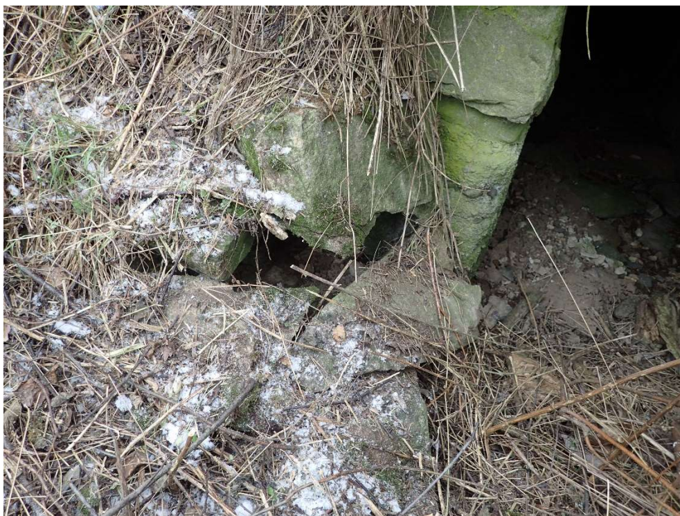
Foto 4: Uvolněné kameny u křídel propustku
